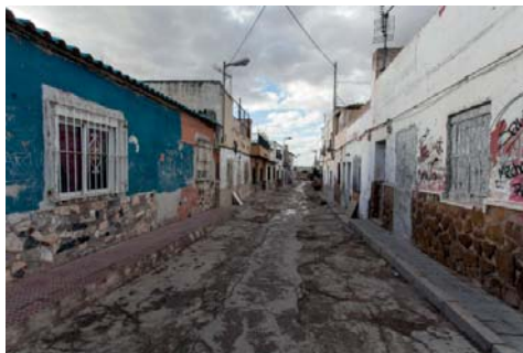
Calle del barrio del cementerio
